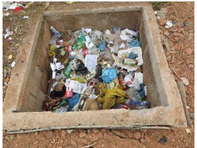
**Foto 3.8 – Detalhe de caixa de drenagem na estrutura de transbordo cheia de resíduos**
